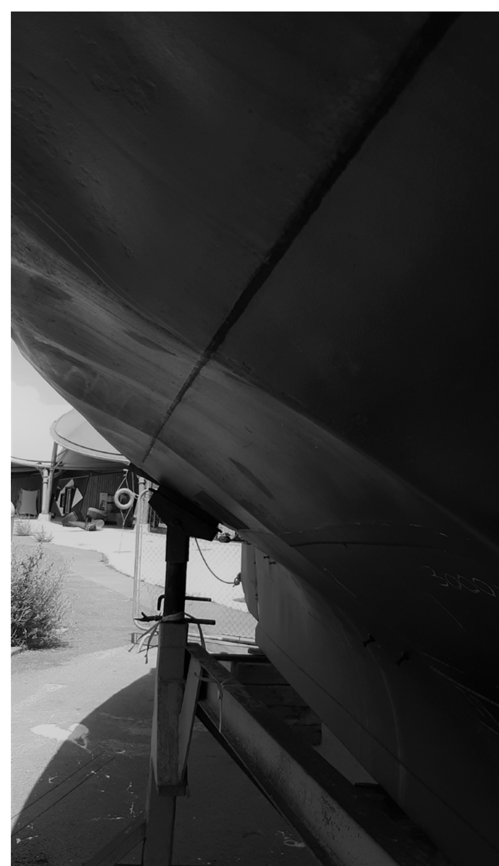
Déformation de la coque
